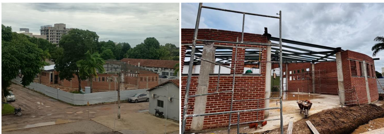
Figura 9 Obras do Restaurante Universitário do Campus Paulo Freire, fevereiro de 2025
